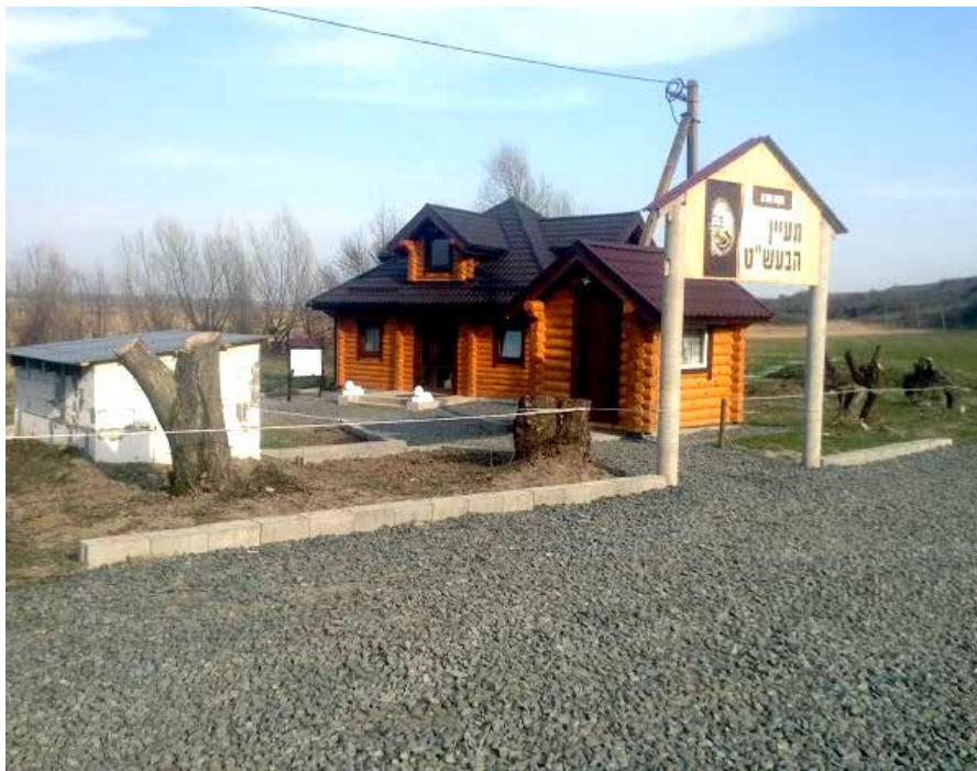
די געביידע וועלכע איז אויפגעשטעלט געווארן אויפן קוואל אין וועלכען דער הייליגער בעש"ט פלעגט זיך טובל זיין, און איז לעצטענס געפונען געווארן אין מעזשיבאזש.
